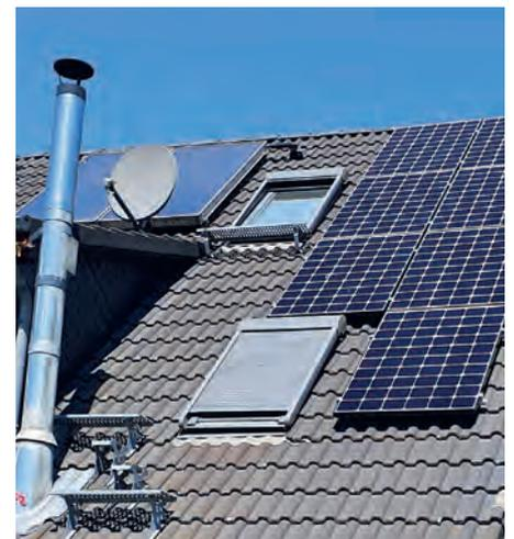
Abb. 4: Solarthermik (links oben) und Photovoltaik (rechts) nutzen Sonneneinstrahlung zur Erzeugung von Wärme und elektrischer Energie.
